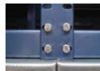
Detalles del montaje
